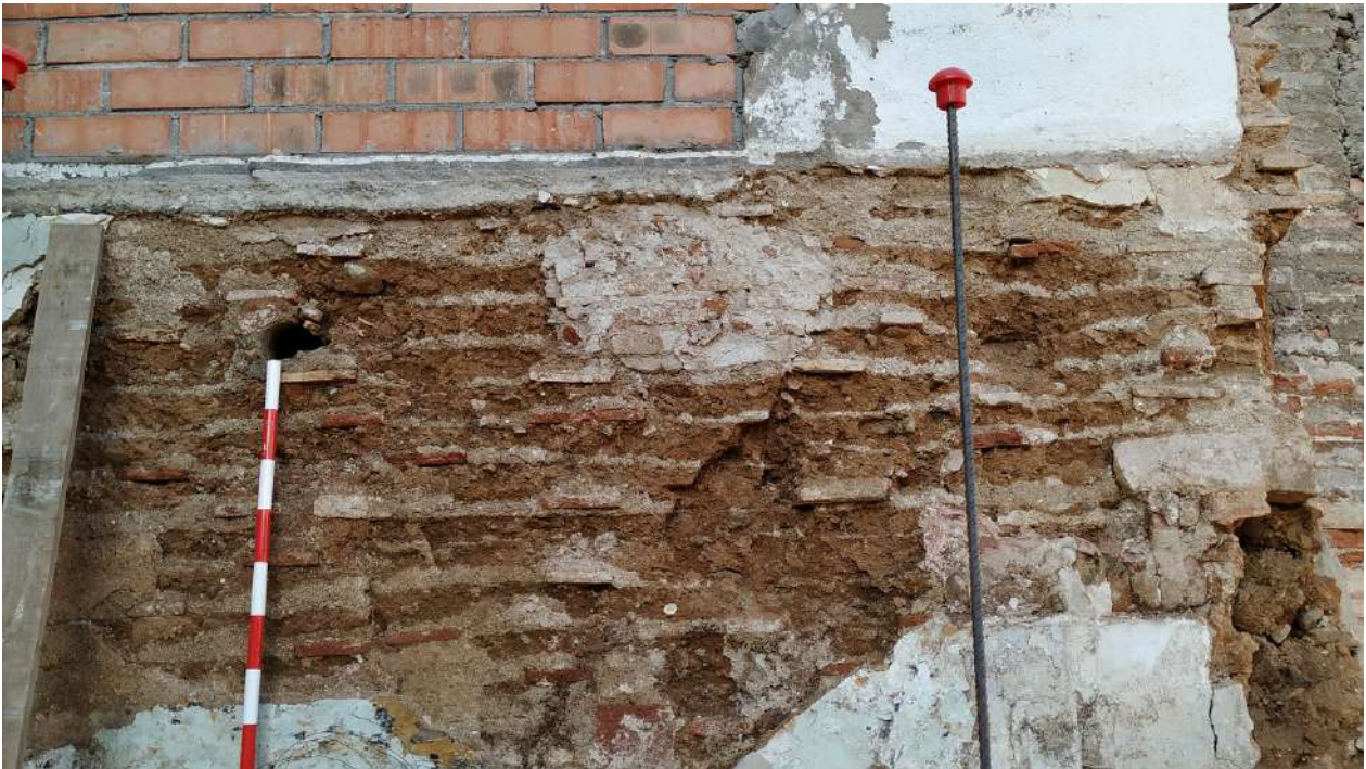
7.- Vista de detall del mur de tàpia UE 019.
