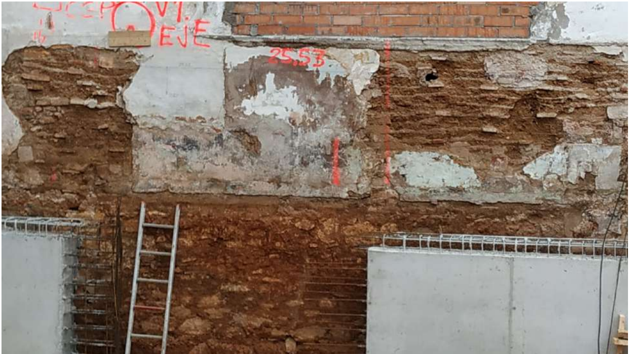
20.- Vista del procés de construcció del tancament perimetral per trams del nou edifici. Aquest transcorre paral·lel a la paret de tàpia UE 019, a la fonamentació UE 021 i al revestiment UE 022 sense entrar en contacte amb elles.
