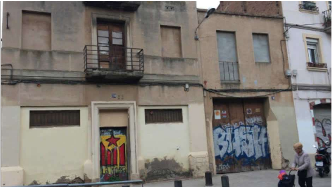
1.- Vista de la façana de les finques núm. 18 i 20 amb anterioritat a la seva demolició i conversió en solar, pas previ a les tasques d'excavació objecte de seguiment. Imatge extreta del projecte d'enderroc 1 .
