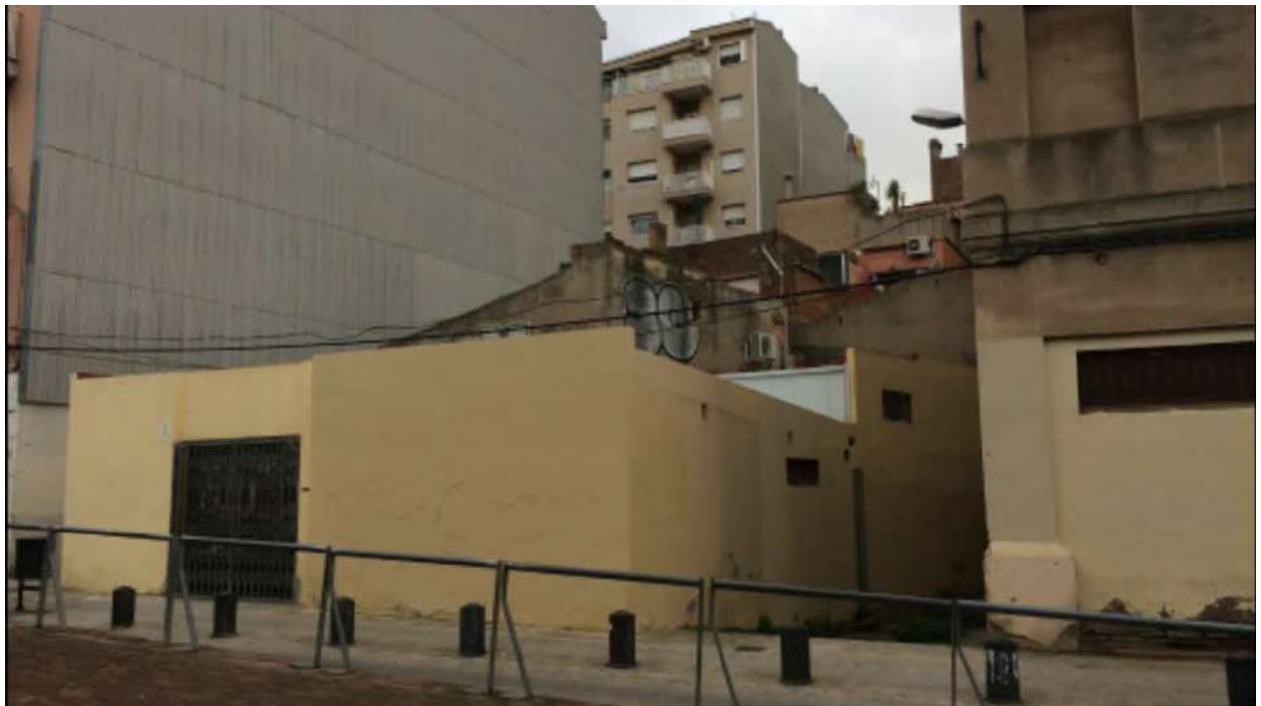
2.- Vista de la façana de les finques núm. 24 i 26 amb anterioritat a la seva demolició i conversió en solar, pas previ a les tasques d'excavació objecte de seguiment. Imatge extreta del projecte d'enderroc 1 .
