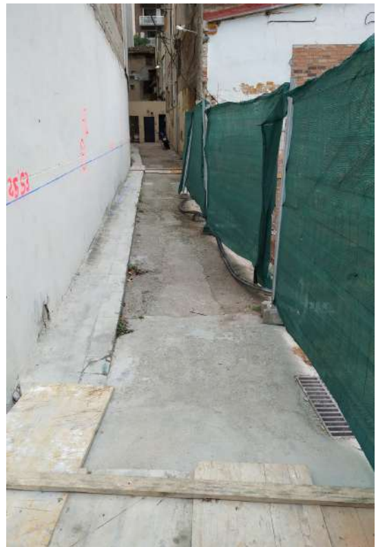
16.- Primer pla del carreró entre la finca núm. 26 -ja enderrocada- i la finca núm. 28.
