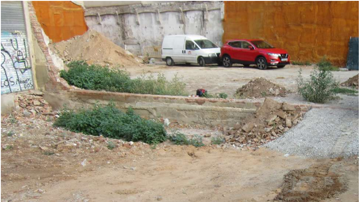
18.- Vista general de la paret mitgera UE 015.
