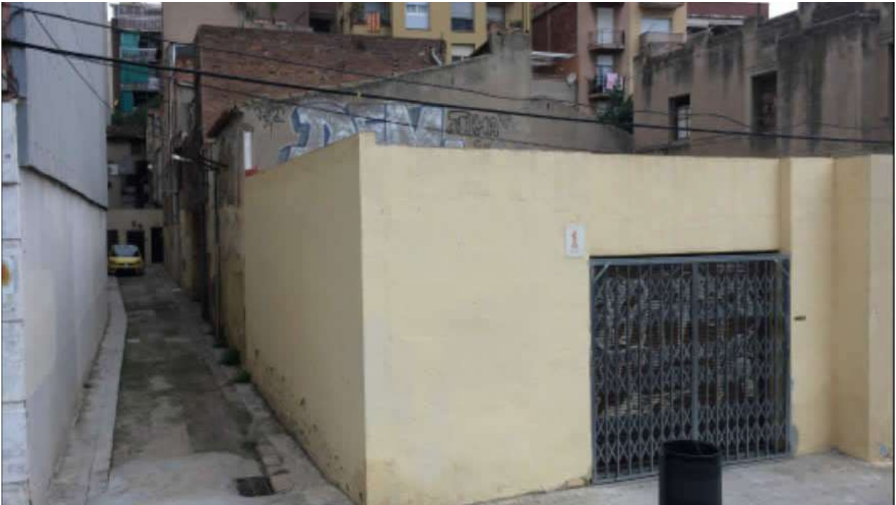
3.- Vista del carreró entre la finca núm. 26 -amb anterioritat a la seva demolició- i la finca núm. 28. Imatge extreta del projecte d'enderroc 2 .
